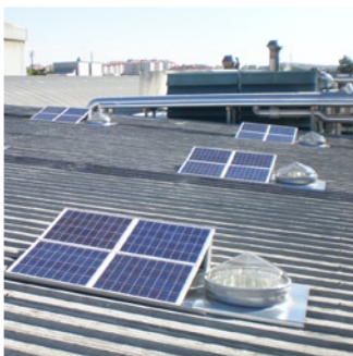
1- Aplicação em painel sandwich
