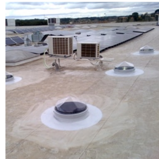
2- Cubierta con rejilla de recubrimiento de pvc
